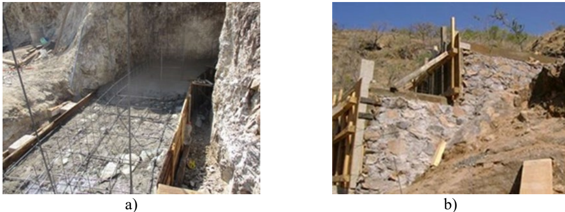
Figura 2. Construcción de taludes: a) Elaboración de base de desplante, b) Construcción de Talud.
