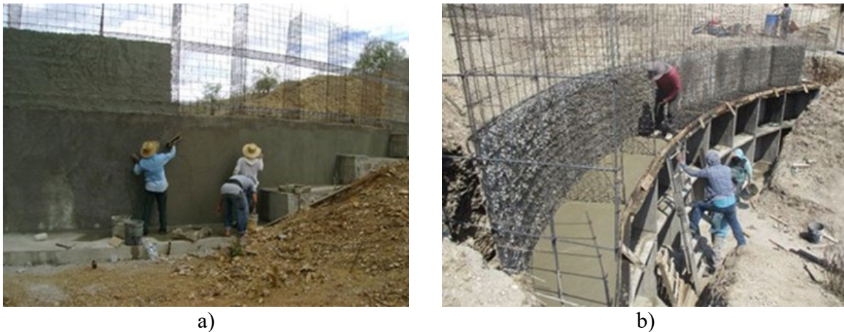
Figura 7. a) Acabado final del muro, b) Colado del tímpano en la parte posterior de la represa.
