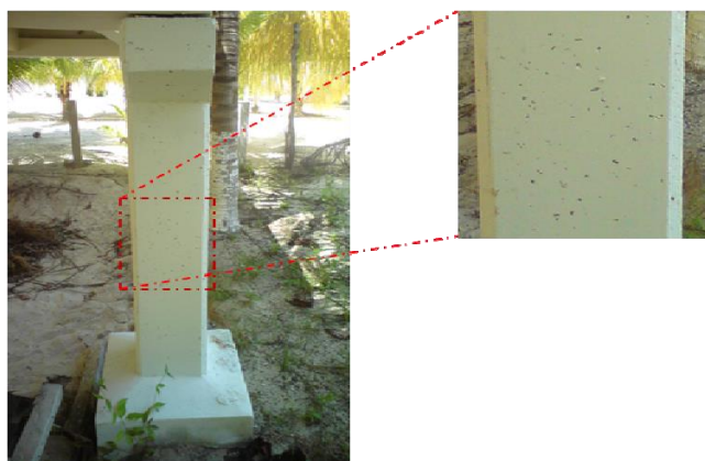
Figura 2. Porosidad en la cara este de la columna A
