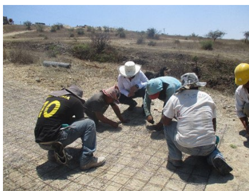
Figura 5. Tejido de mallas para elaboración de muro, cartabones y tímpanos
