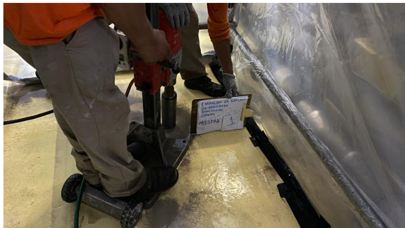
Figura 3. Extracción de núcleos
