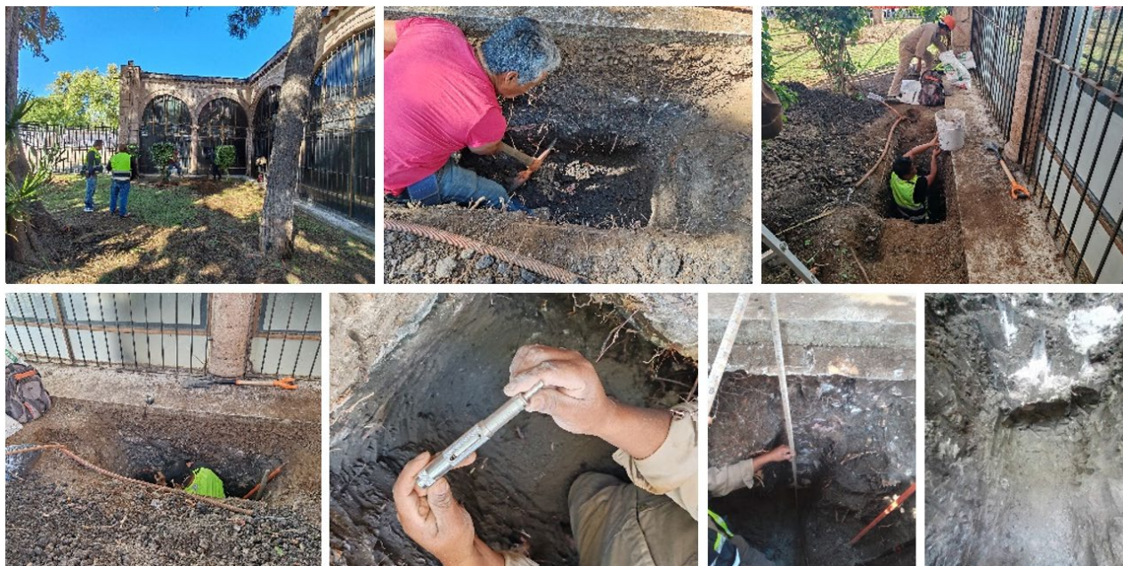
Figura 3. Proceso de excavación y muestreo de los pozos a cielo abierto (PCA).
