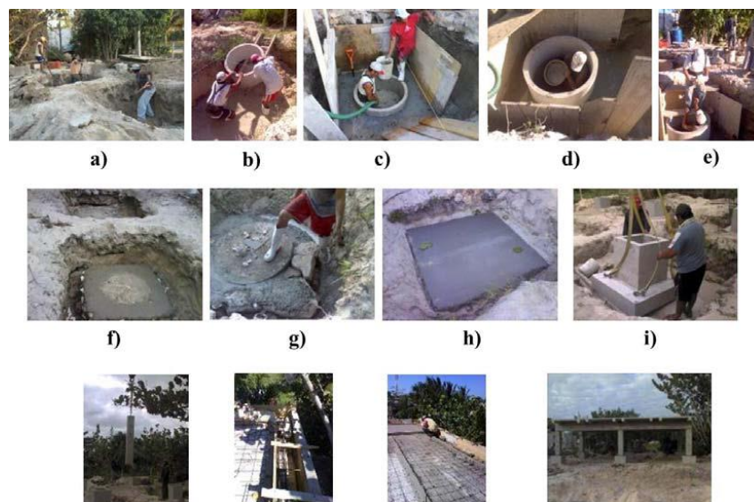
Figura 3. Instalación y ensamblaje de la subestructura tipo palafito.
