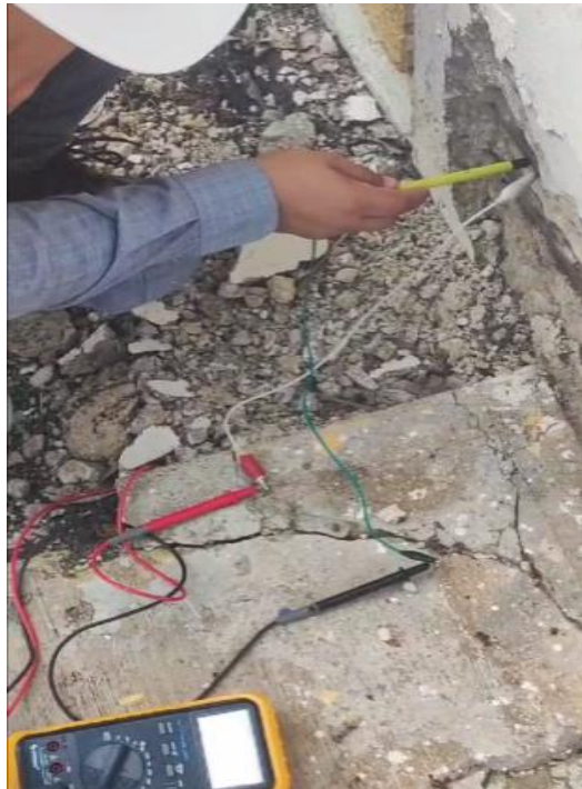
Figura 6. Medición del potencial en sitio.
