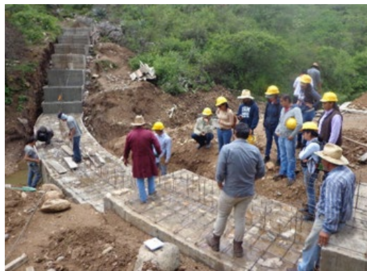
Figura 3. Construcción de la base de cimentación
