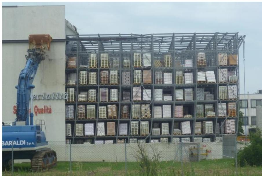
Figura 4.4. Almacén de pallets. La acción sísmica junto con la masa provocó el fallo de las cruces de San Andrés y el colapso de los cerramientos (Norte de Italia, 2012)
