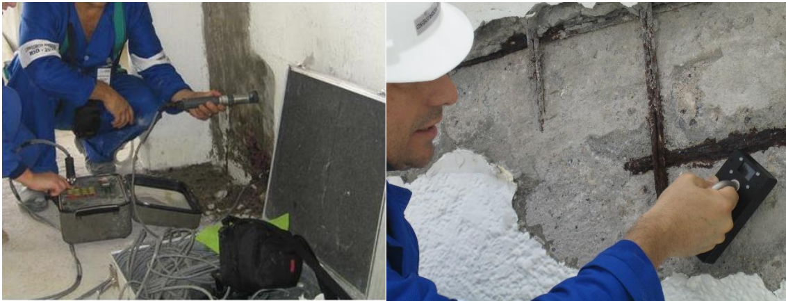
Figura 8. Retirada de la pintura y el recubrimiento para hacer la medida directamente sobre el hormigón
