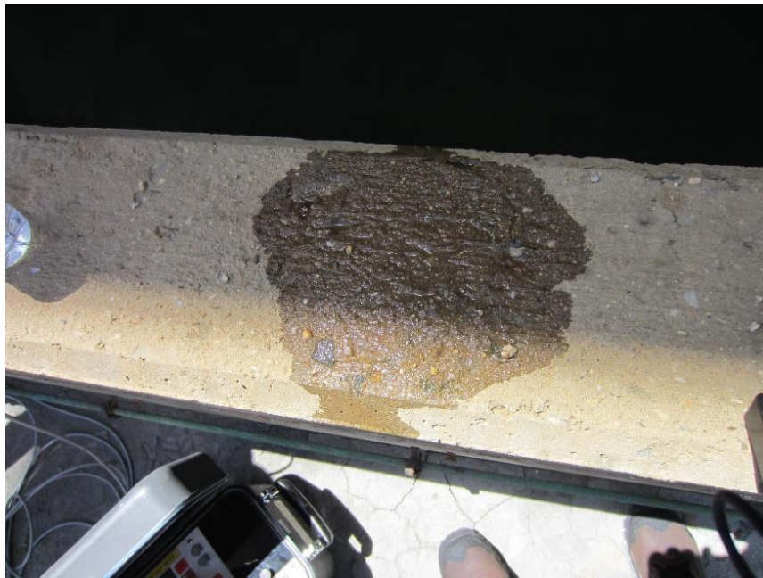
Figura 6. Mojado de la superficie del hormigón antes de realizar la medida de resistividad
