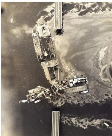
Fig. 2- Vista aérea del choque con 2 Pilas del PGRU.
