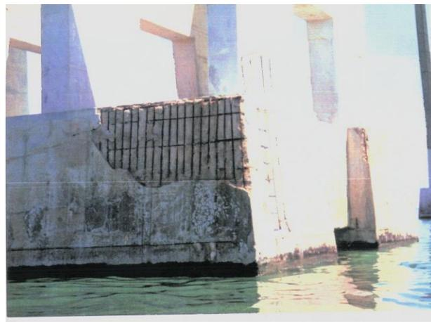
Fig. 3- Nótese la corrosión del acero de refuerzo en una de las Pilas del PGRU.
